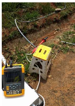
FIGURA 48 – MEDIÇÃO DE RESISTÊNCIA DE CONTATO DO CABO COM A SUPERFÍCIE
