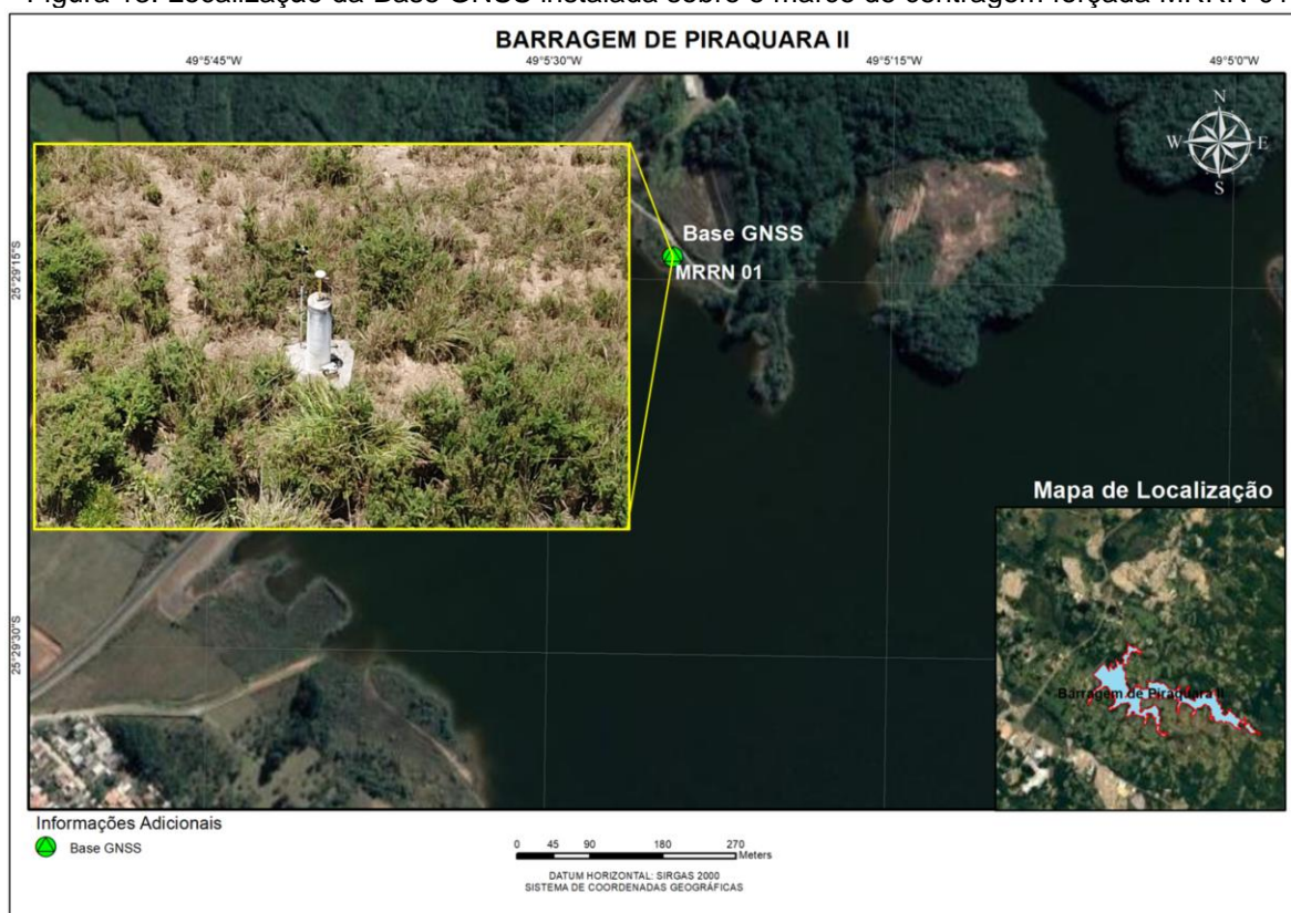
Figura 13: Localização da Base GNSS instalada sobre o marco de centragem forçada MRRN-01
