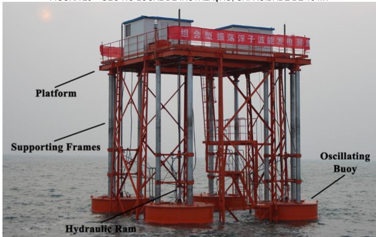
FIGURA 29 – GEO NO LOCAL DE INSTALAÇÃO, CAPACIDADE DE 10 kW
