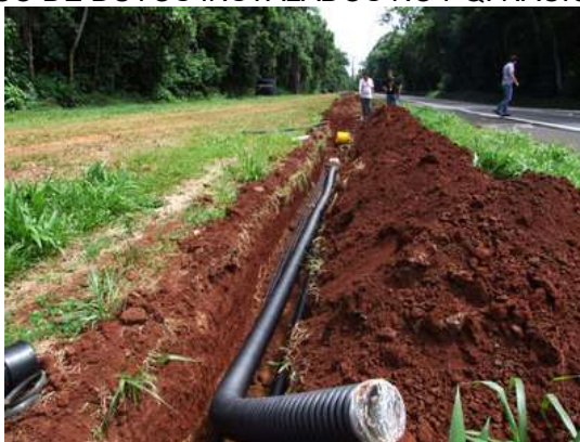
FIGURA 5 - BANCO DE DUTOS INSTALADOS NO PQ. NACIONAL DO IGUAÇU
