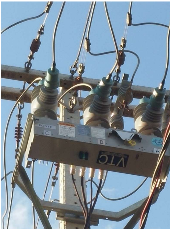
FIGURA 12 - RELIGADOR AUTOMÁTICO UTILIZADO PARA PROTEÇÃO DE RDS
