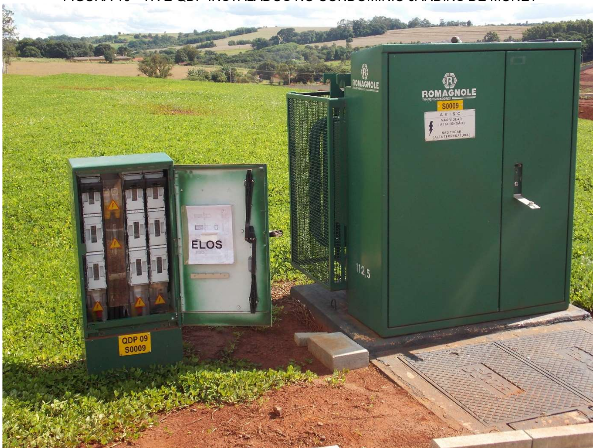
FIGURA 10 - TR E QDP INSTALADOS NO CONDOMÍNIO JARDINS DE MONET
