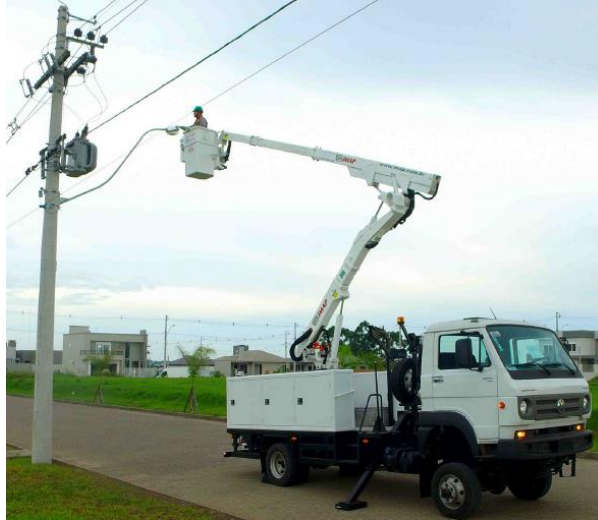
FIGURA 14 – CAMINHÃO COM IMPLEMENTO DO TIPO CESTO AÉREO
