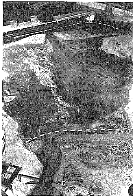
CONSTRUÇÃO DE ENSECADEIRA EM ÁGUA CORRENTE (APROVEITAMENTO HIDRELÉTRICO DE S. SIMÃO)
