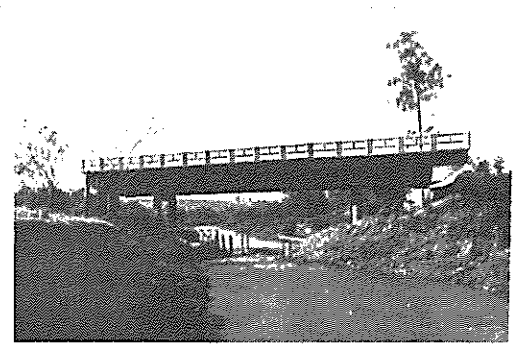
Ponte sobre o rio Sapiranga. Vista lateral da ponte depois de executado o levantamento.
