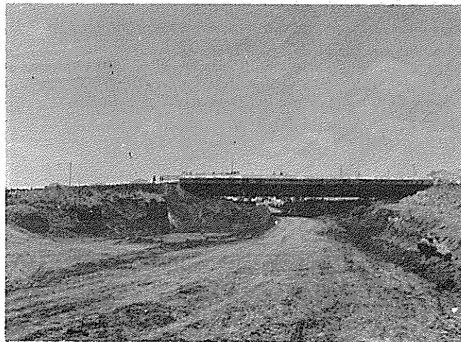
Viaduto para Trevo Tuiuti - Colombo
