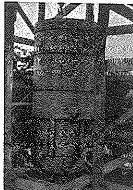
Fundações em tubulações a ar comprimido para a ponte sobre o rio Manoel Alves.
